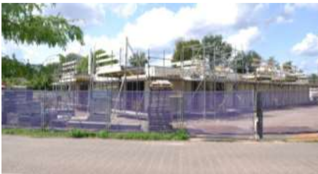
Bouw appartementencomplex siloterrein in 2019
