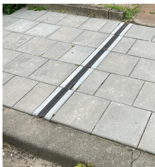
Figuur 2 voorbeeld principe kabelgoottegel (links) en foto van de kabelgoottegel in Winterswijk (rechts)
